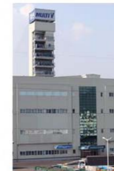
Проверка работы системы при удалении блоков системы друг от друга по вертикали
